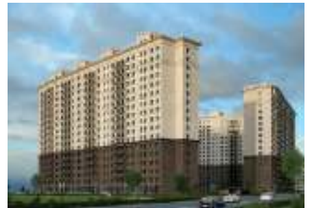
ЖК Котельнические высотки (МО, г.Котельники) 2017г.
